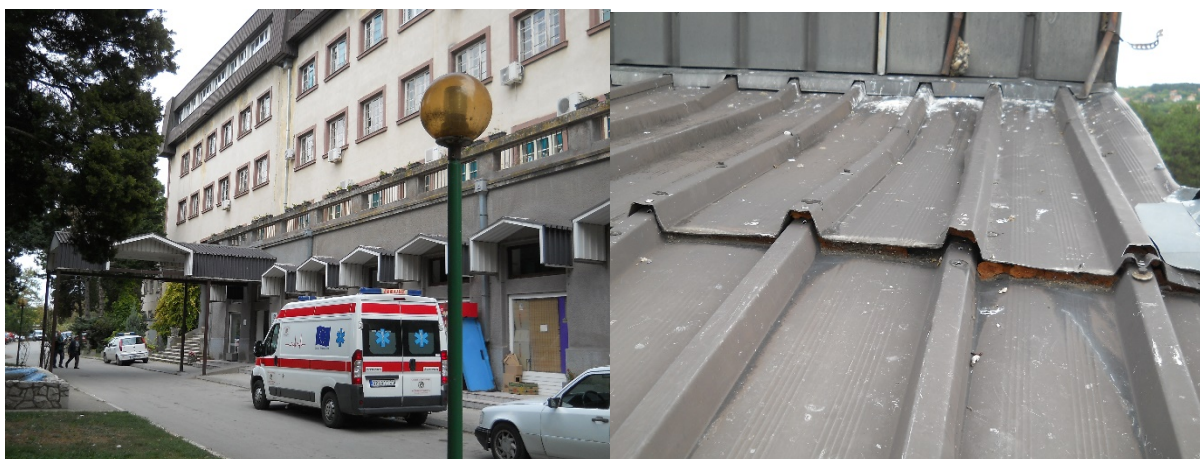
Фото бр. 1 – Предњи део Главног објекта Фото бр. 2 – Кровни покривач
